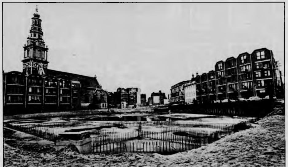
Bauen auf dem Metrodach: Spezialfundament (Bildmitte), links und rechts die ersten Neubauten von Theo Bosch
